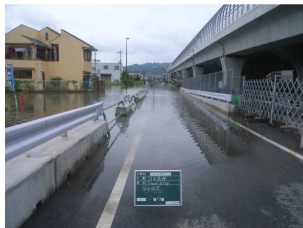
写真－2 国道1号(第二京阪)交野市内での冠水状況
