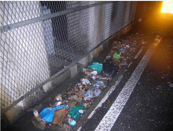
写真-4 冠水後の状況
