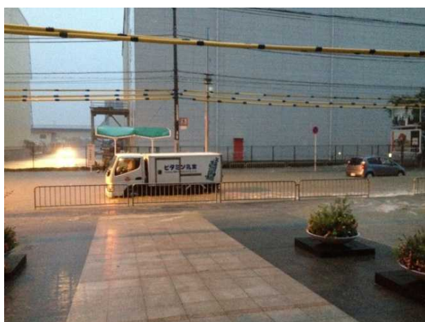
写真－1 国道171号高槻市内での冠水状況
