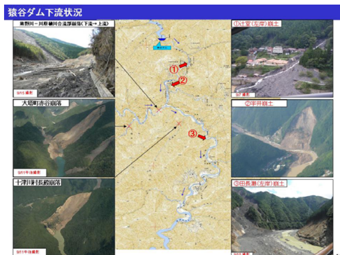
図-2 猿谷ダム下流状況
