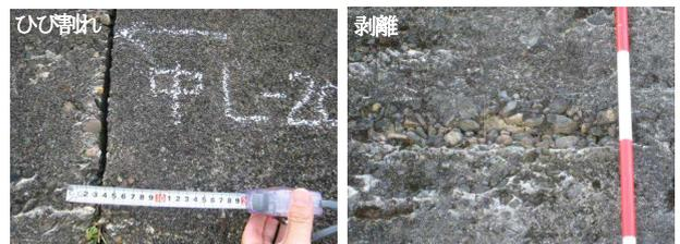
写真-5 損傷の状況
