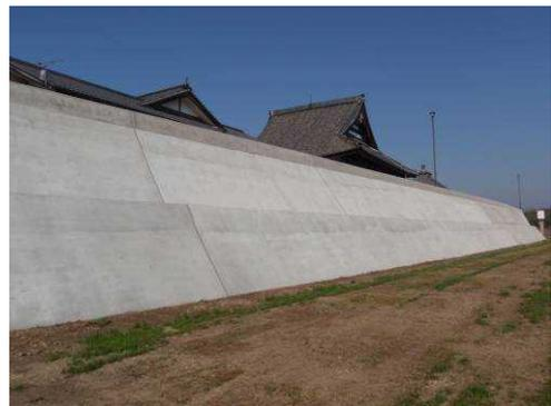
**写真-8** 補修箇所の施工後の状況
