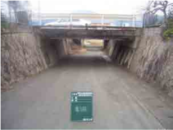
写真-1 着手前 (既設床版橋の状況)
