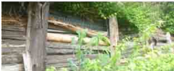
写真-20 施工事例Dの間伐材の状態
