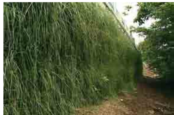
写真-1 チェーンウォール工法外観
