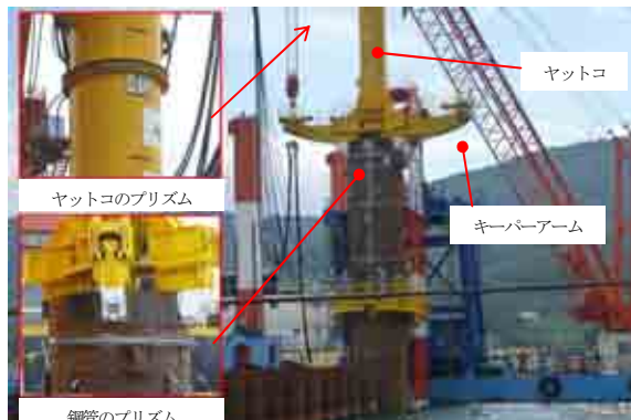
図-13. パイルキーパーと反射プリズム
