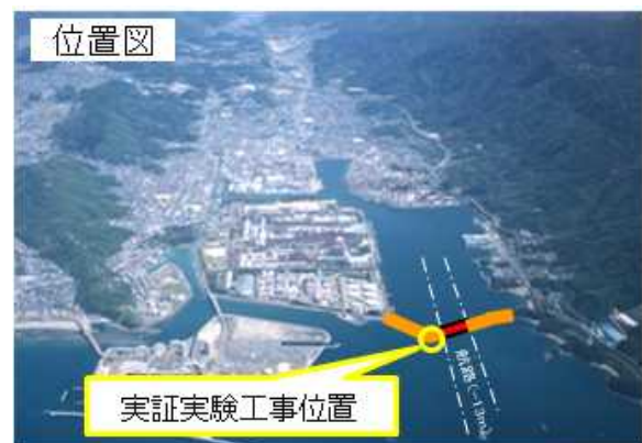
図-6 実証実験工事の位置
