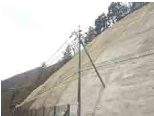
写真4.4 事例2 施工完了
