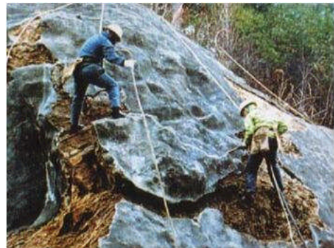
写真-1 はつり取り作業状況（例）
