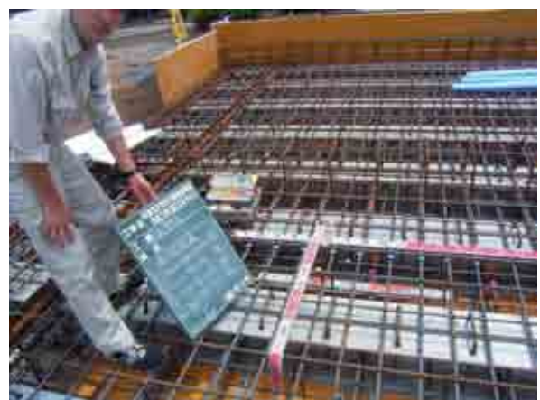
写真-7 鉄筋組立状況
