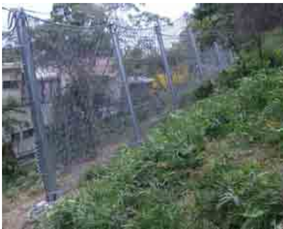
写真－1 柔構造斜面崩壊対策待受け工設置事例
