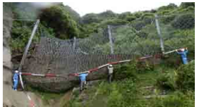
写真-3 土砂を捕捉した例
