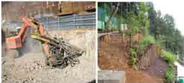
写真-14 硬質な岩盤 写真-15 植樹可能となった斜面
