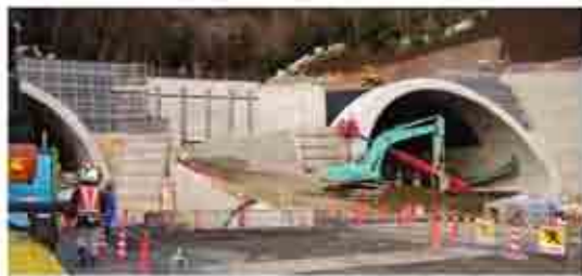
写真-7 自然の姿とは程遠い施工中
