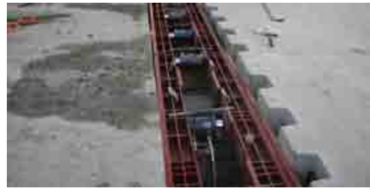
図-14 軸力導入状況
