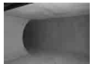
写真7 接続部（管路側）
