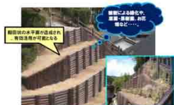
写真-3 階段状の水平面と植樹状況
