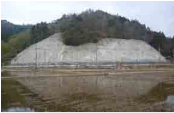
写真4.2 事例1 施工完了
