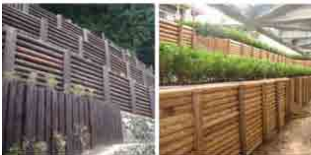
写真-21 防腐処理剤を塗布した間伐材
