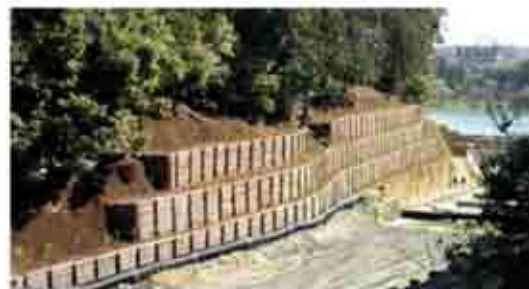
写真-5 間伐材に覆われた完成直後
