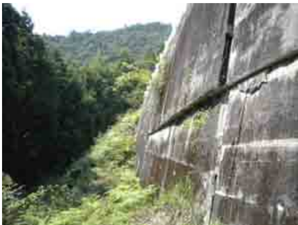
写真-3 施工前の本現場の外観
