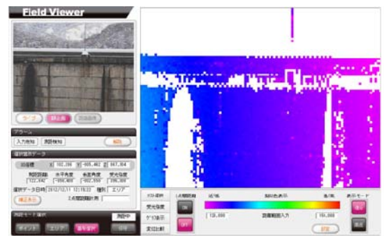
図-6 コンクリートが黒色化している場合
