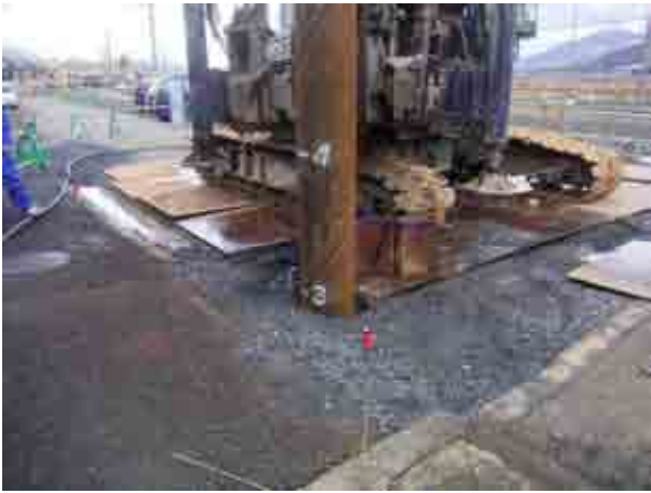
写真-2 基礎工 (鋼管杭基礎打設状況)
