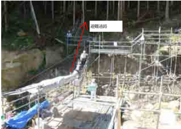
写真-6 足場設置状況
