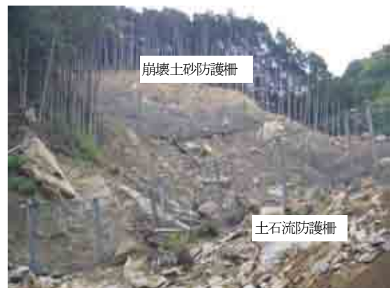
写真-8 工事完成
