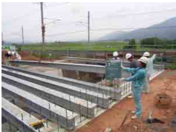
写真-5 桁架設状況
