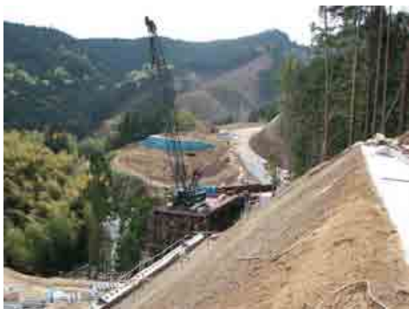
写真-2 仮栈橋工事
