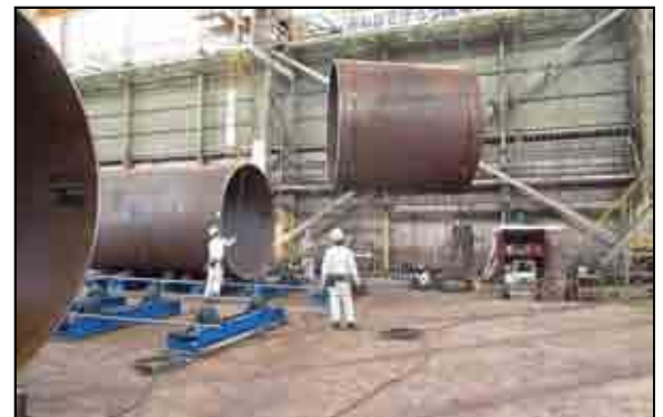
図-10. 鋼管のつなぎ合わせ
