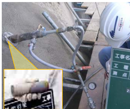
写真4.7 事例4 注入状況
