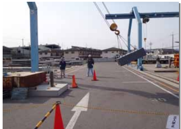
写真-6 10kNの重錘を0.35m引き上げた状況
