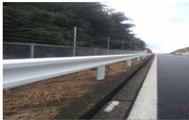
写真-9 完成状況
