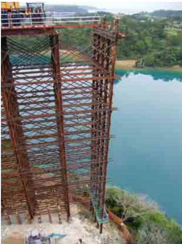
写真－7 2005 年施工・ワルミ大橋
