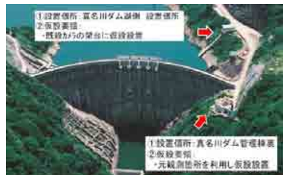
図-2 真名川ダムにおける機器設置箇所
