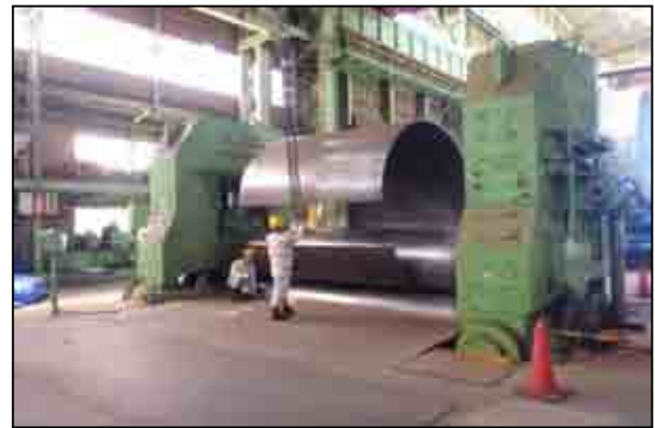
図-9. 鋼材の板巻き
