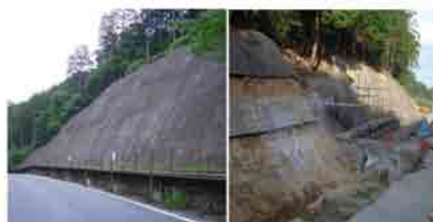
写真-4 コンクリート吹付の現状と撤去状況
