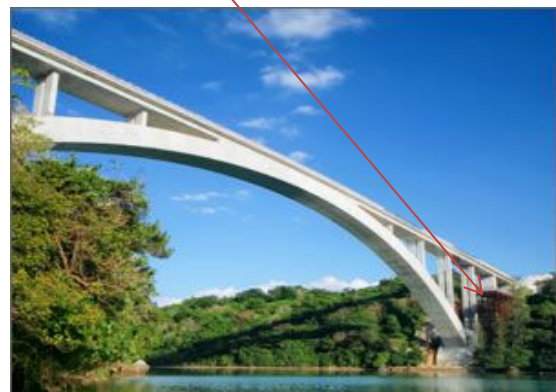
写真－9 ワルミ大橋工事中の全景
