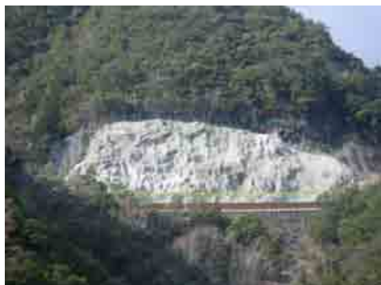
写真4.8 事例4 施工完了
