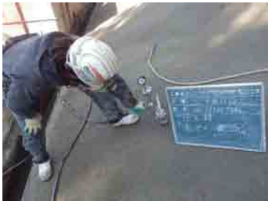
写真4.3 事例2 空隙充填状況
