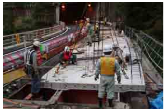
図-13 H S Lスラブ架設状況
