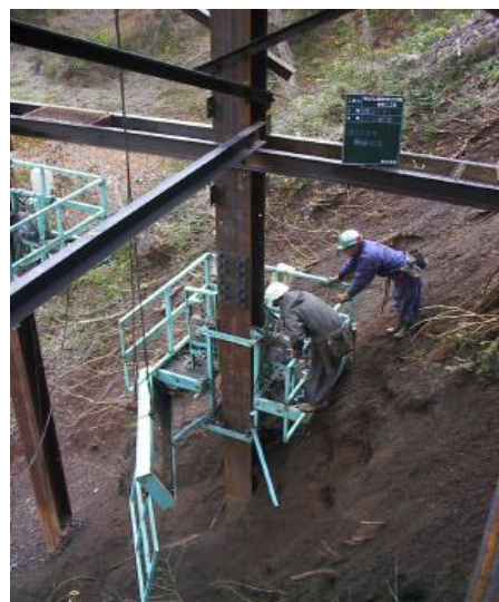
写真-6 足場用ゴンドラ撤去作業
