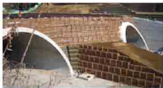
写真-8 施工直後の南側坑口
