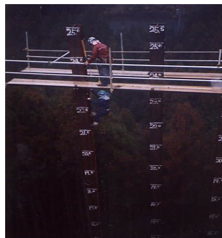
写真-4 作業員の昇降作業
