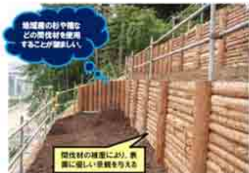
写真-2 間伐材の取付状況
