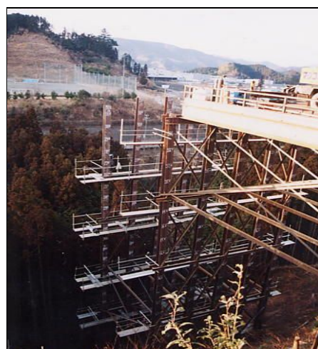
写真-3 従来方式の足場（作業床）
