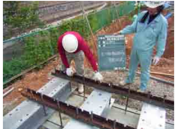
写真-6 上下連結金具設置状況
