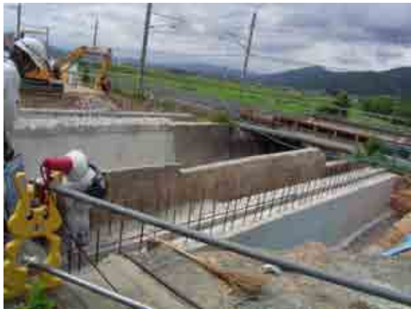
写真-4 下部工完成
