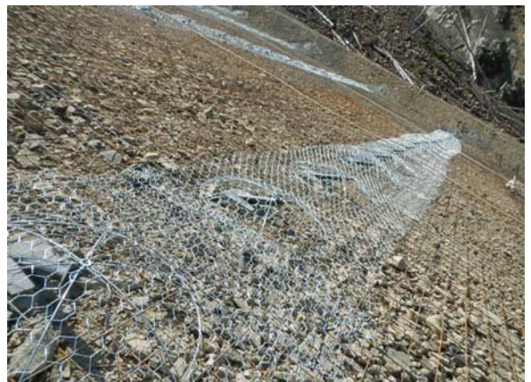
写真-3 お椀状の鉄筋籠設置完了
