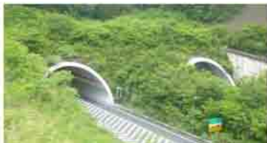
写真-9 7年が経過した現在の状態
