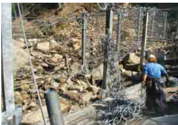
写真-7 リングネット取付状況
