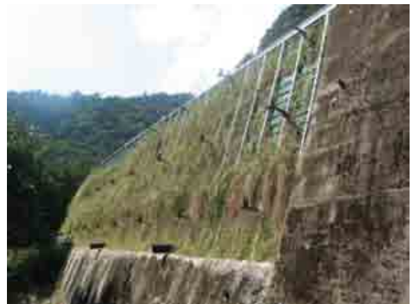
写真-4 補強土壁のターゲット設置状況
