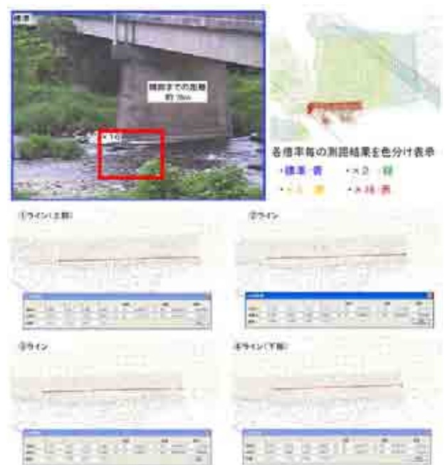
図-12 橋脚の水面付近の測距状況
