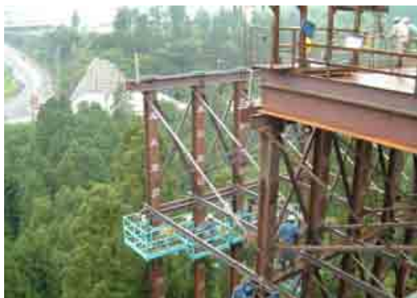
写真-5 足場用ゴンドラ作業風景
