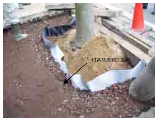
写真-1 廃瓦を利用した根の生育空間の確保
