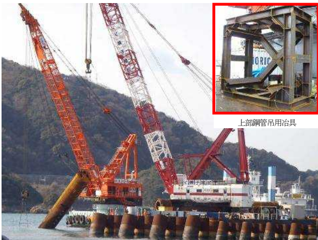
図-16. 起重機船2隻による上部鋼管建て起し
