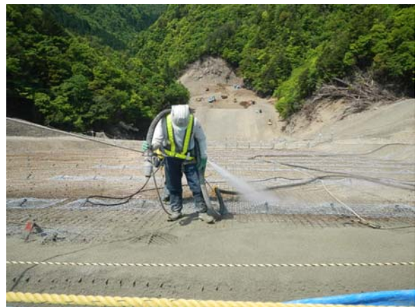
写真-4 斜仮排水路吹付け状況
