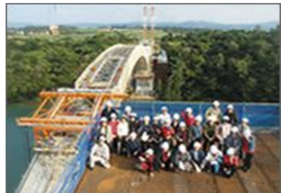
写真－8 仮棧橋上での見学会風景
