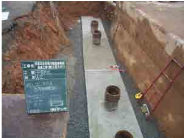
写真-3 下部工均しコンクリート打設状況
