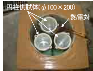
写真-4 型枠設置状況
