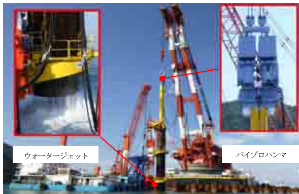
図-12. 下部鋼管打設の様子
