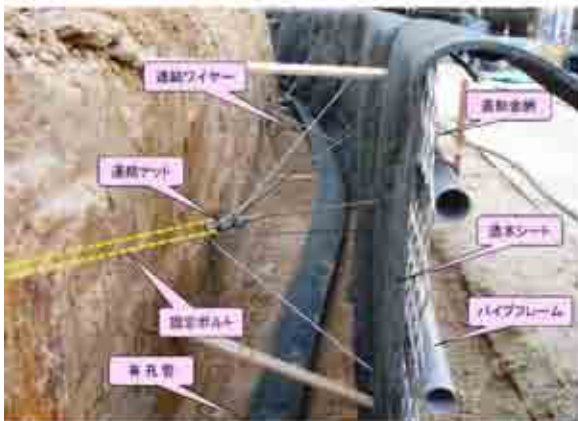
写真-1 全天候フォレストベンチ工法の背面構造
