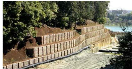
写真-5 間伐材に覆われた完成直後
