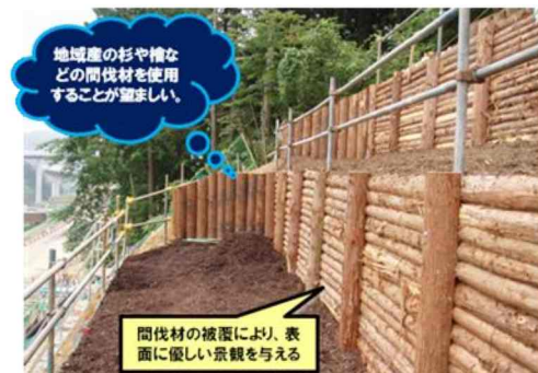
写真-2 間伐材の取付状況
