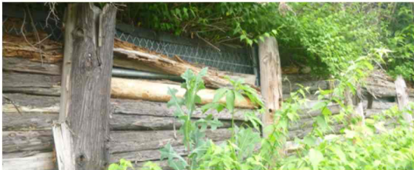
写真-20 施工事例Dの間伐材の状態
