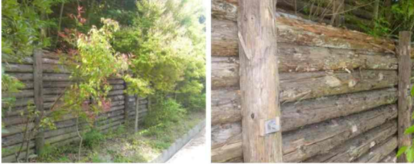
写真-19 施工事例Aの間伐材の状態
