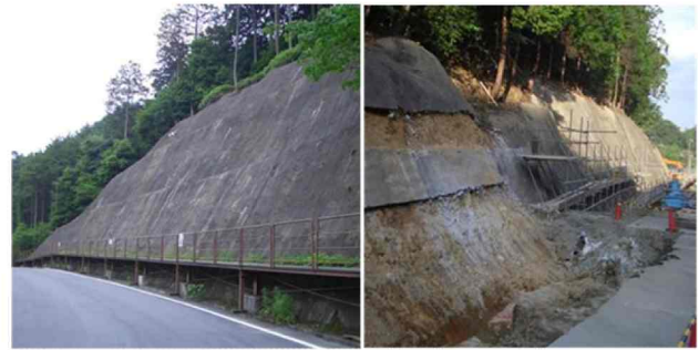
写真-4 コンクリート吹付の現状と撤去状況
