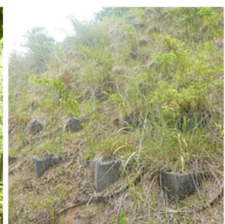
写真-12 従来工法の現況
