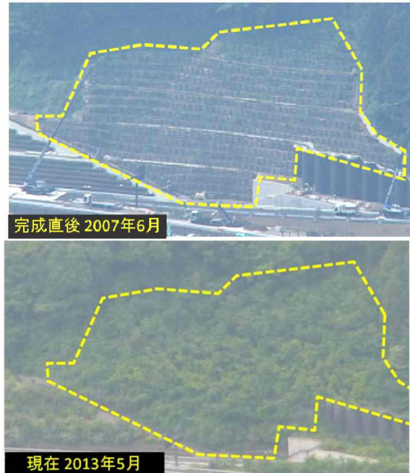
写真-17 完成直後と現在の西側斜面の状況
