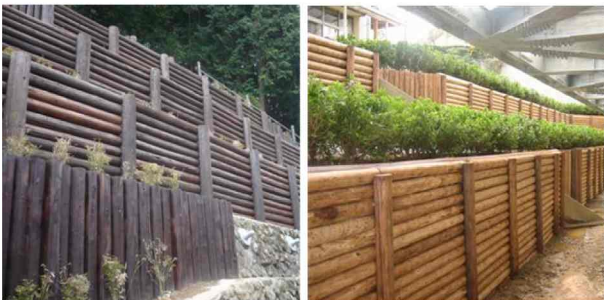
写真-21 防腐処理剤を塗布した間伐材
