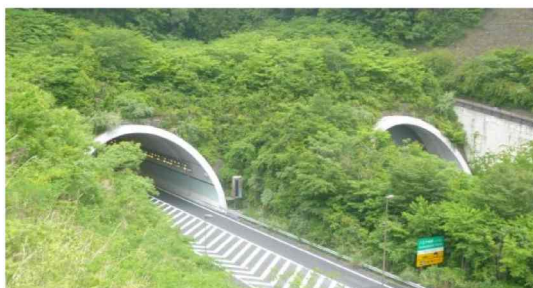
写真-9 7年が経過した現在の状態
