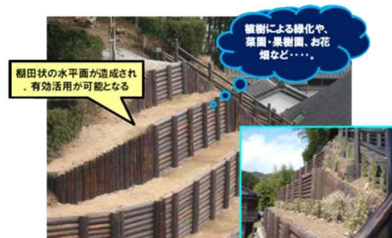
写真-3 階段状の水平面と植樹状況
