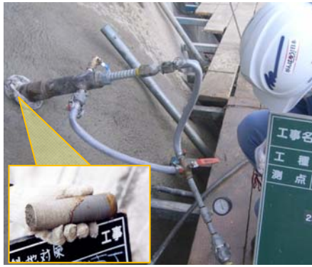
写真4.7 事例4 注入状況
