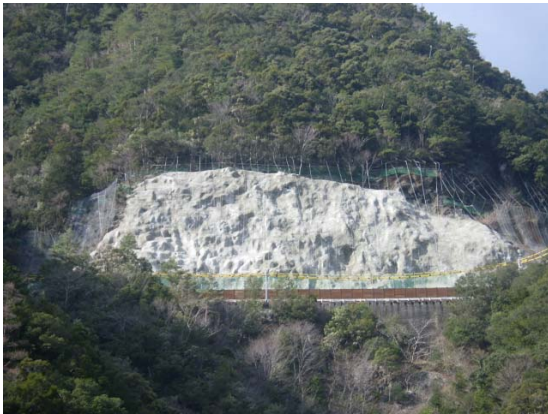
写真4.8 事例4 施工完了
