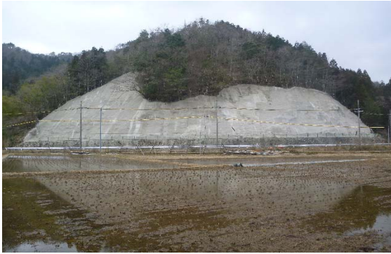
写真4.2 事例1 施工完了
