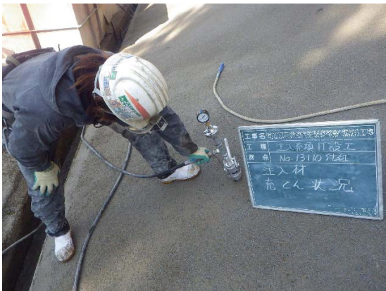
写真4.3 事例2 空隙充填状況
