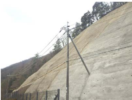
写真4.4 事例2 施工完了
