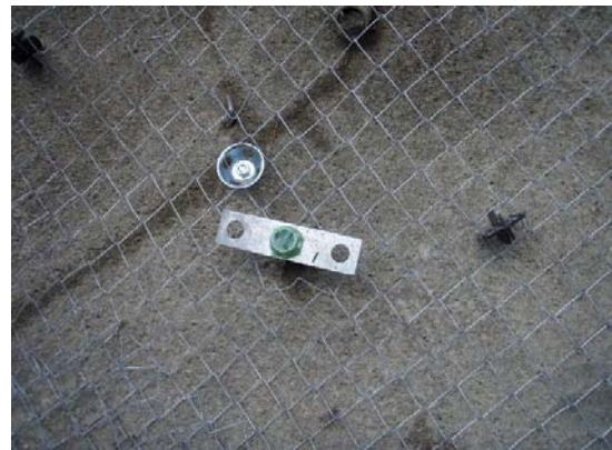
写真4.6 事例3 カップルボルト(上)とグラウチングボルト(下)
