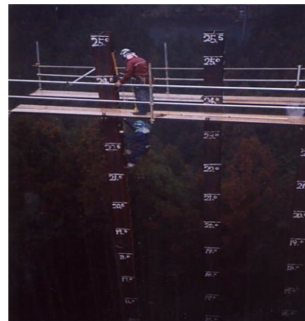
写真-4 作業員の昇降作業
