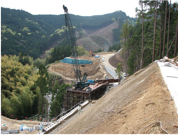
写真-2 仮栈橋工事
