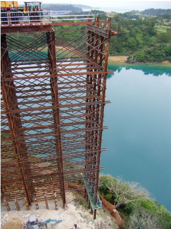
写真－7 2005 年施工・ワルミ大橋
