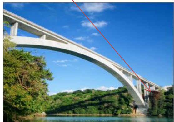
写真－9 ワルミ大橋工事中の全景
