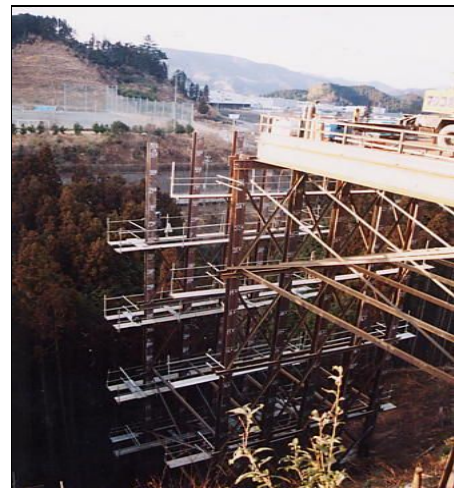
写真-3 従来方式の足場（作業床）
