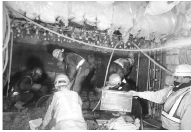
写真-1 凍土掘削
