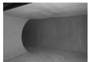
写真7 接続部（管路側）
