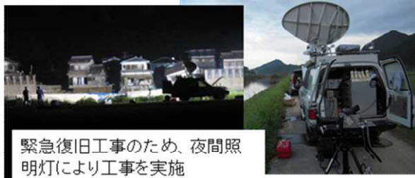
緊急復旧工事中の映像送信状況
