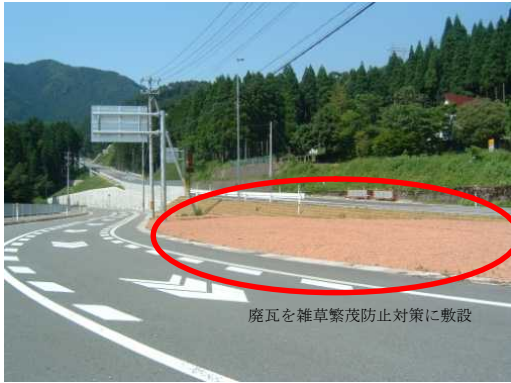
写真-2 雑草繁茂防止対策に廃瓦を敷設
