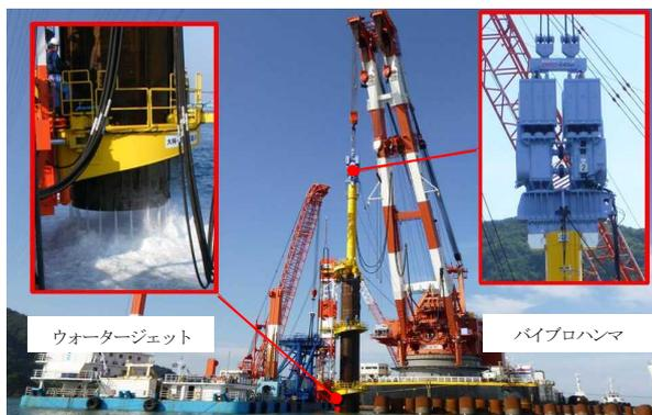
図-12. 下部鋼管打設の様子
