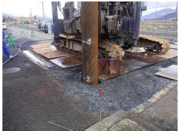
写真-2 基礎工 (鋼管杭基礎打設状況)
