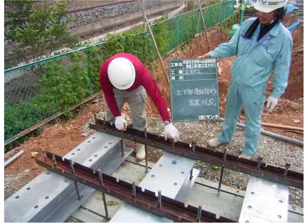
写真-6 上下連結金具設置状況
