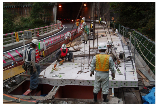
図-13 H S Lスラブ架設状況
