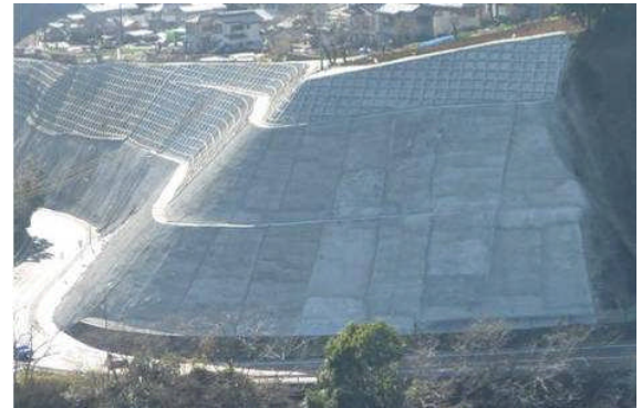
写真-2 適用事例① (上段；施工前，下段；施工後)
