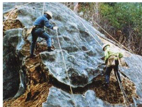
写真-1 はつり取り作業状況（例）
