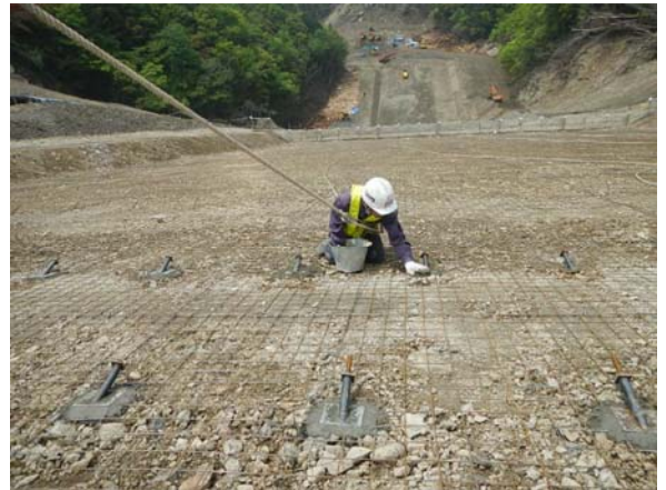
写真-2 アンカーバーヘッド設置状況
