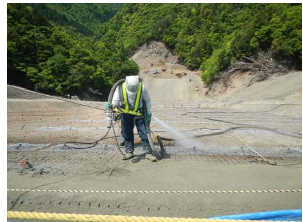
写真-4 斜仮排水路吹付け状況
