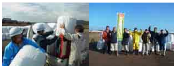
写真6 (左) サポート状況、(右) 積込みサポート隊
