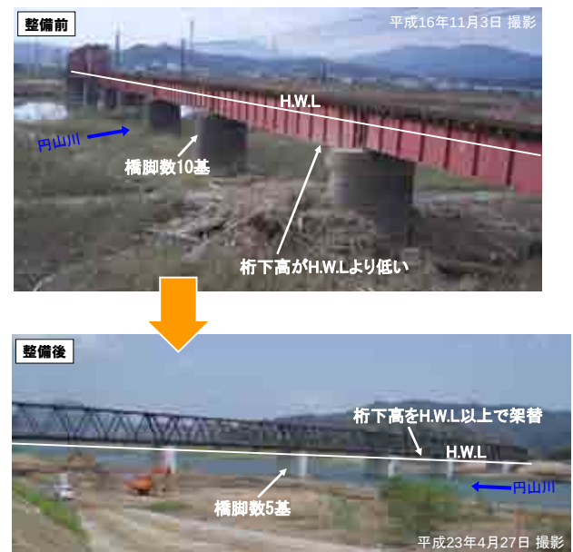
図-4 洪水を阻害する橋梁の架替(KTR円山川橋梁の架替)
