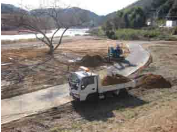
村による基盤の復旧作業状況
