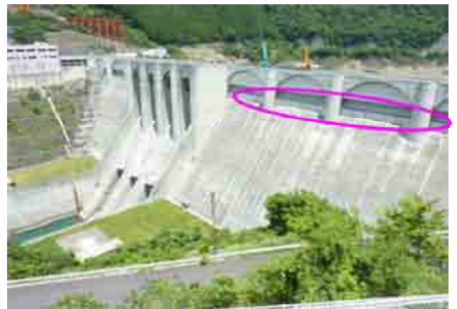
＜大滝ダムの外部栈橋＞
