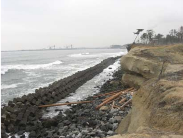
図-3 自然海岸の消波堤
