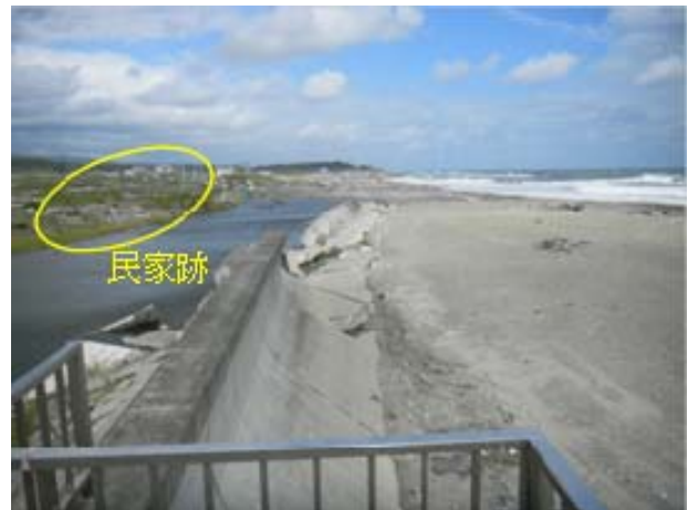
図-6 民家跡が密集する海岸沿いの様子
