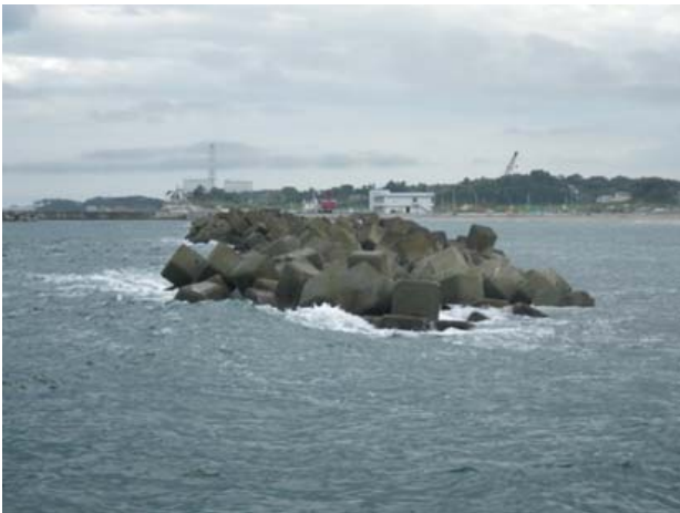
図-4 沖にある離岸堤
