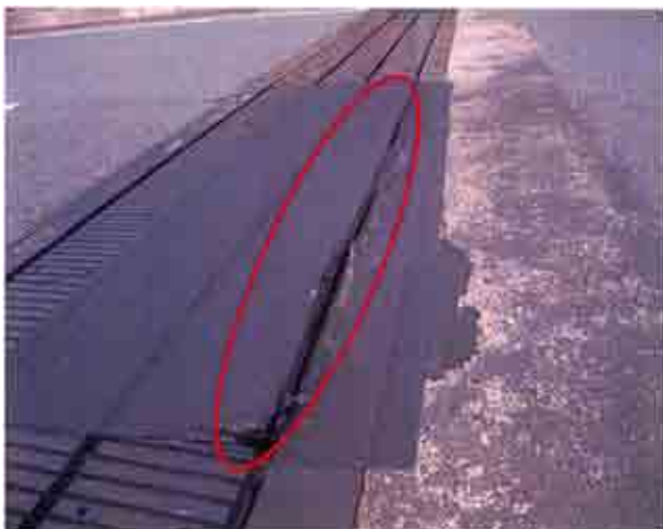
図-6 即時保守業務として対応困難な破損事例 (橋梁ジョイント部の破損)
