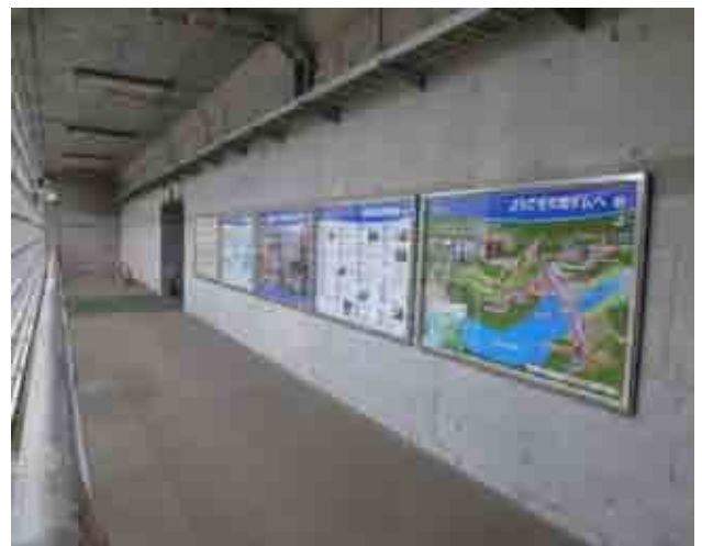
＜ダムの中みち（外部栈橋）＞
