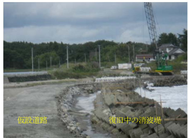
図-8 担当した消波堤復旧工事
