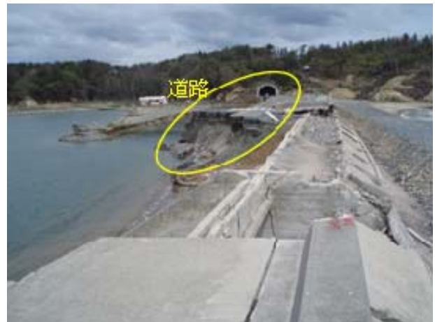
図-5 海岸堤防（左側が内海、右側が外海）
