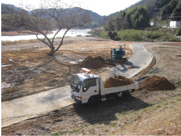
村による基盤の復旧作業状況
