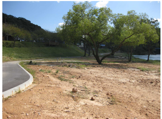
冠水により基盤が荒れた状況
