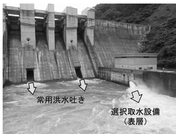
図-6 出水後期の混合放流状況
