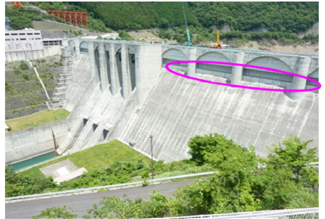
＜大滝ダムの外部栈橋＞
