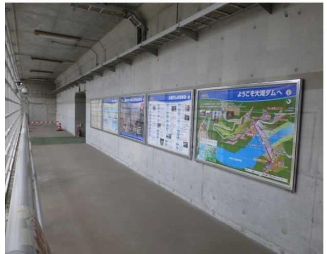
＜ダムの中みち（外部栈橋）＞
