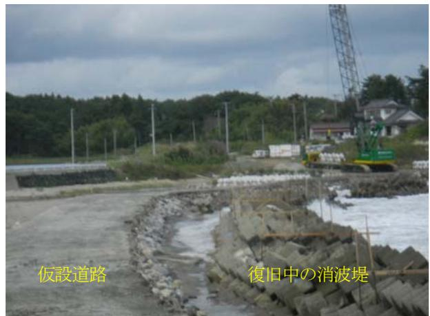
図-8 担当した消波堤復旧工事
