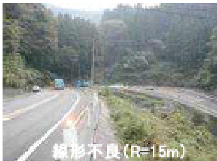
写真1. 国道178号道路現況
