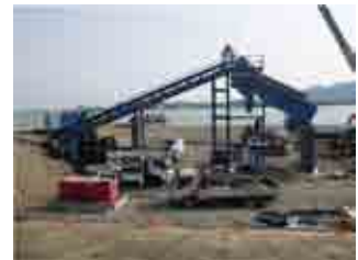
写真-5 ふるい分け機の状態
