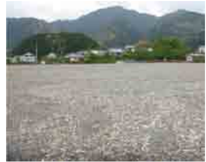
写真-15 土砂搬入完了状況
