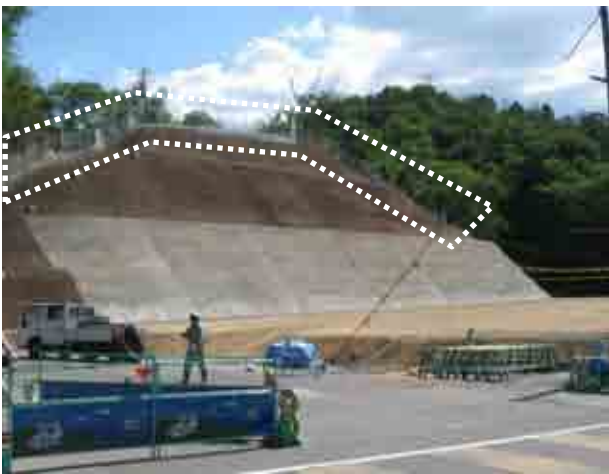
写真－3 ゲート室部背面の法面（近景）
