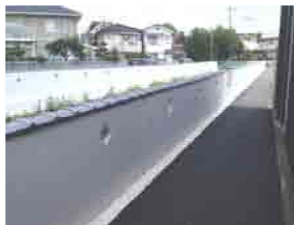
写真-2 護岸工事で整備した白壁パラペット
