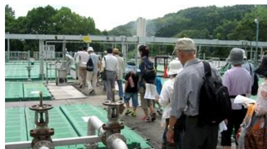
写真-8 山田川浄化センターの見学説明会
