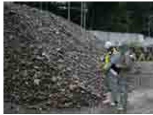
写真-12 掘削土砂仮置き状況
