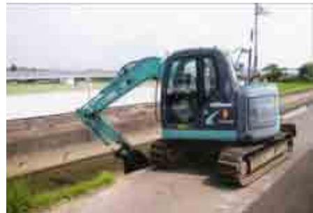
写真-10 上狛川の浚渫作業
