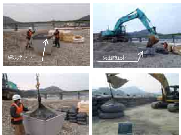
写真-10 ユニットの製作状況
