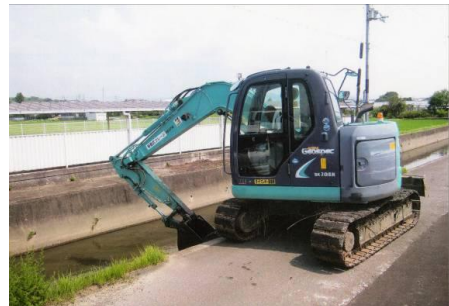
写真-10 上狛川の浚渫作業
