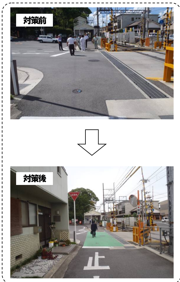
写真-5 河合大和高田線の対策
