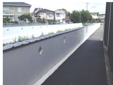
写真-2 護岸工事で整備した白壁パラペット
