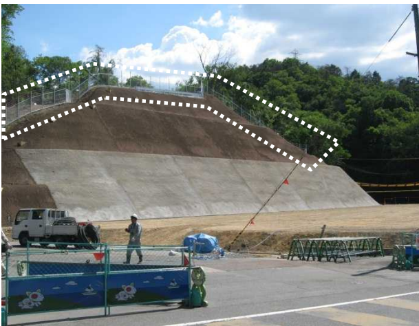
写真－3 ゲート室部背面の法面（近景）
