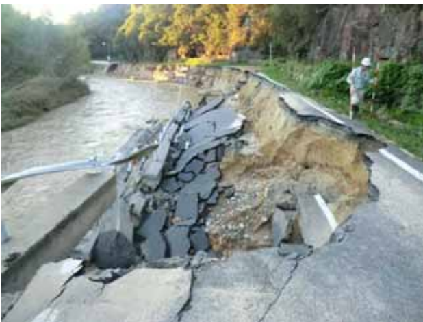
図-5 大津信楽線 道路損壊 大津市上田上牧地先
