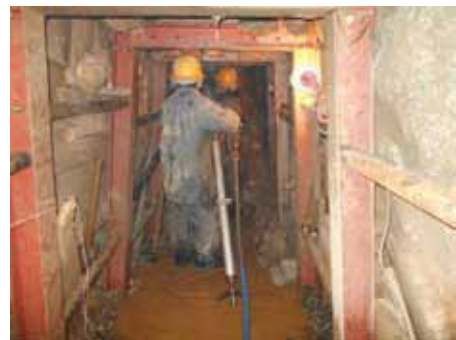
写真-6 掘進状況
