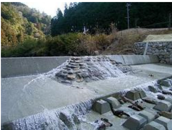
図-13 寄石(スロープ)完成写真
