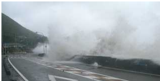
図-1 越波被害の様子
