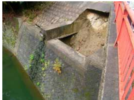
図-5 護岸損傷状況写真
