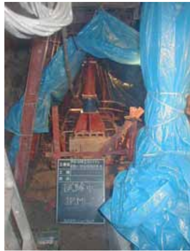
写真-4 ブロックせん断試験状況(試験中)
