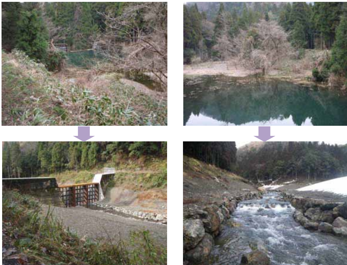
図-5 堰堤上流側の整備前（上）と整備後（下）
