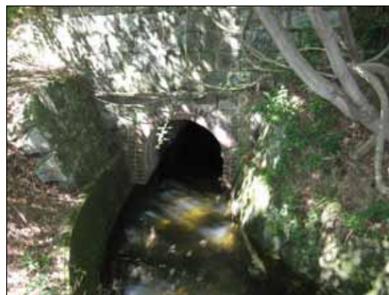
写真-1 淡河幹線水路トンネル入口
