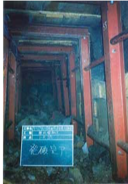
写真-3 横坑掘削状況（発破完了時）
