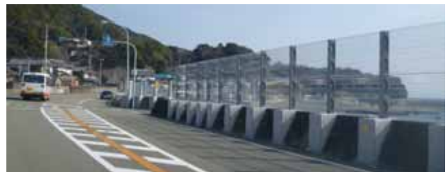
図-12 ポリカーボネート製透光越波防止柵
