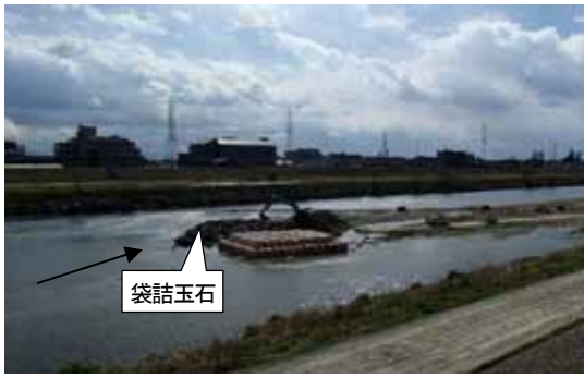
図-6：施工状況（瀬・淵）
