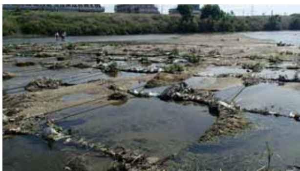
図-12: 袋詰玉石の連結ロープに漂着したビニール袋
