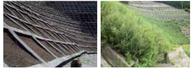
写真-5 平成17年度大迫ダム法面植生工事 (左・施工後2ヶ月、右・施工後17ヶ月)
