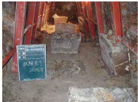
写真-5 ブロックせん断試験状況(試験後)
