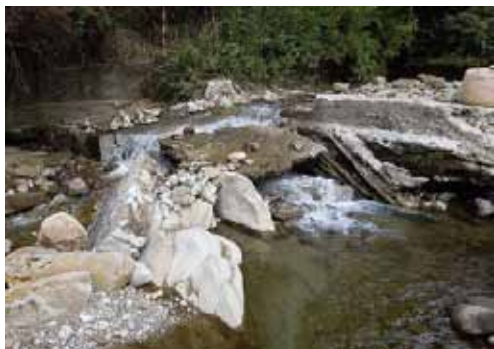
図-4 落差工、水叩き損傷状況写真
