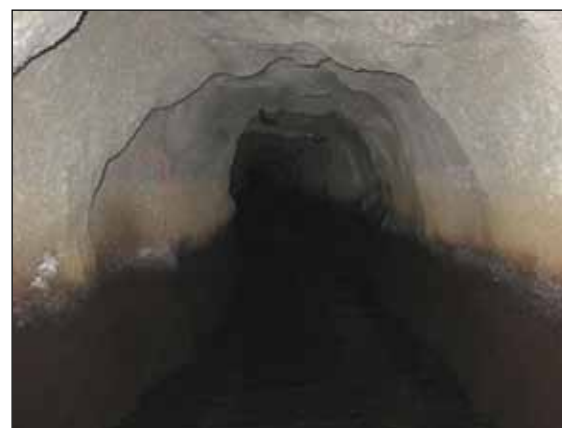
写真-2 山田幹線水路トンネル内部
