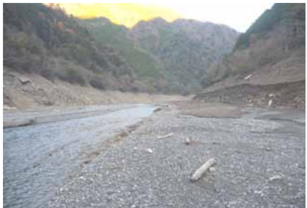
写真-4 河床露出部
