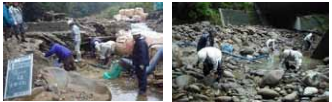
図-8 工事着手時の保護調査状況
