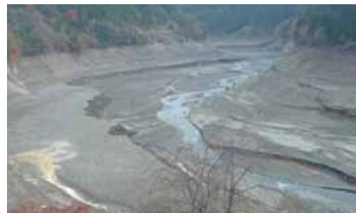
写真-2 入之波大橋上流の堆積状況
