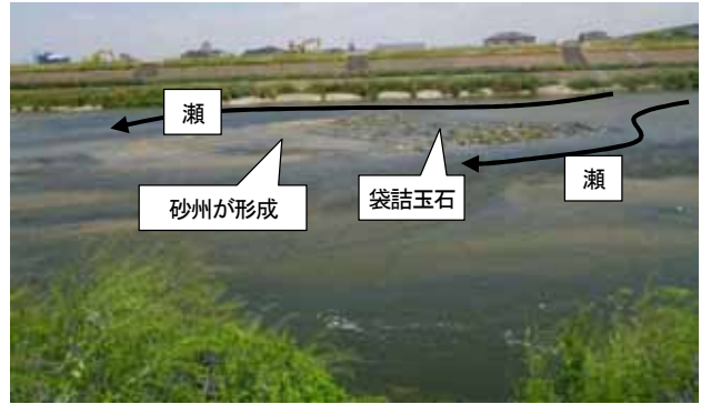
図-9: 瀬・淵再生箇所 (2ヶ月後)
