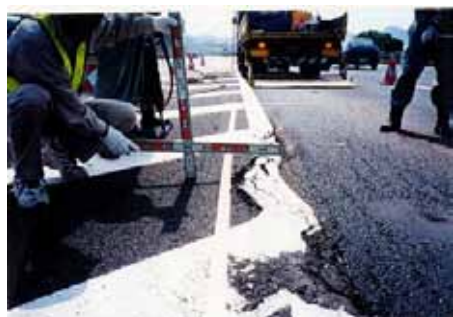
写-1 はく離抵抗性の欠如による早期流動化による損傷事例
