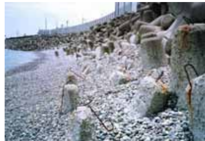
図-11 隙間に砂利が詰まった消波ブロック
