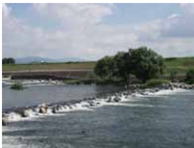
図-3: 既設工法の瀬と淵浄化施設（柏原地区）
