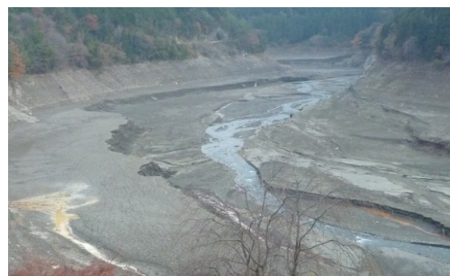
写真-2 入之波大橋上流の堆積状況
