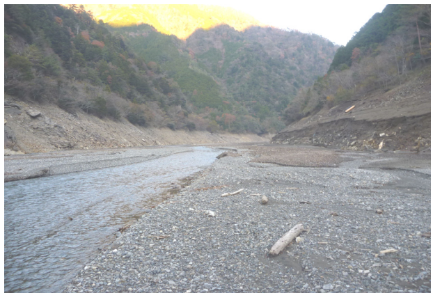
写真-4 河床露出部
