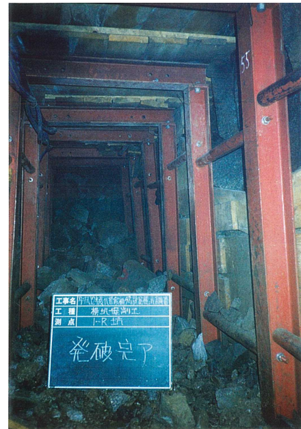
写真-3 横坑掘削状況（発破完了時）
