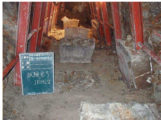
写真5 ブロックせん断試験状況(試験後)
