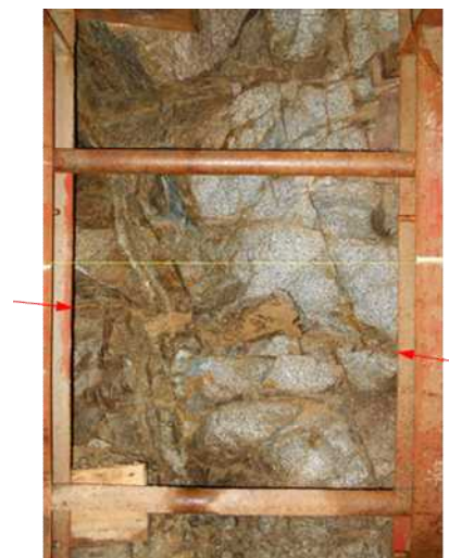
写真-7 4-R坑口から34～35m 上流側側壁状況
