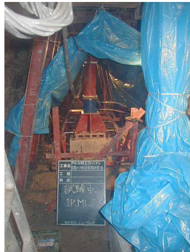
写真4 ブロックせん断試験状況(試験中)
