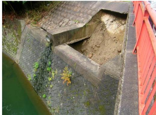
図-5 護岸損傷状況写真
