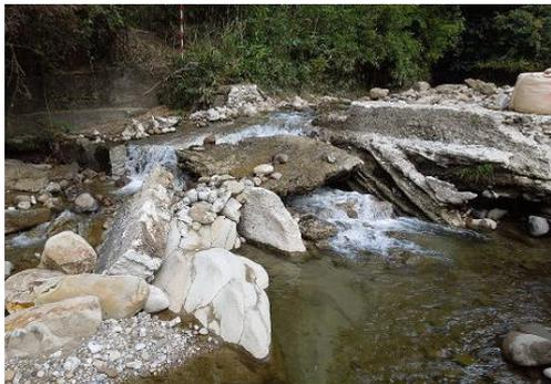
図-4 落差工、水叩き損傷状況写真
