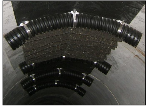
写真-5 コウモリピット設置状況 (新安積)
