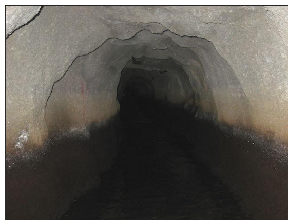
写真-2 山田幹線水路トンネル内部
