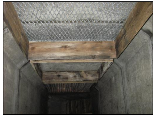
写真-6 コウモリピット設置状況 (平鹿平野)
