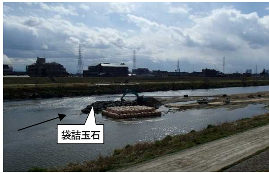
図-6：施工状況（瀬・淵）
