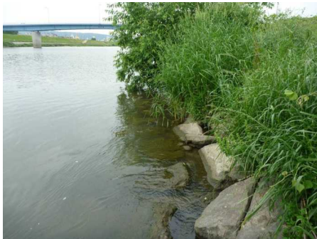
図-7：空石積護岸に定着したヤナギ，セイタカヨシ 等からなる水際植生（大和川左岸15.8k）
