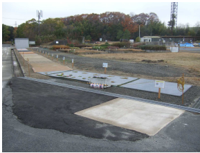
写真-2 完成写真
