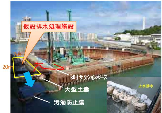
図-15. 仮設排水施設設置状況
