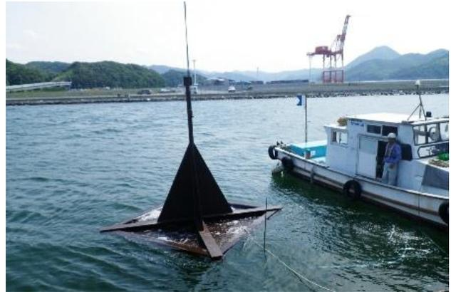
図-8 沈下板設置状況
