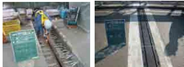
写真 5-3 桁端部切断状況
