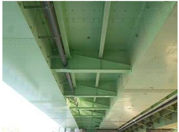
写真 5-5 鋼板接着工
