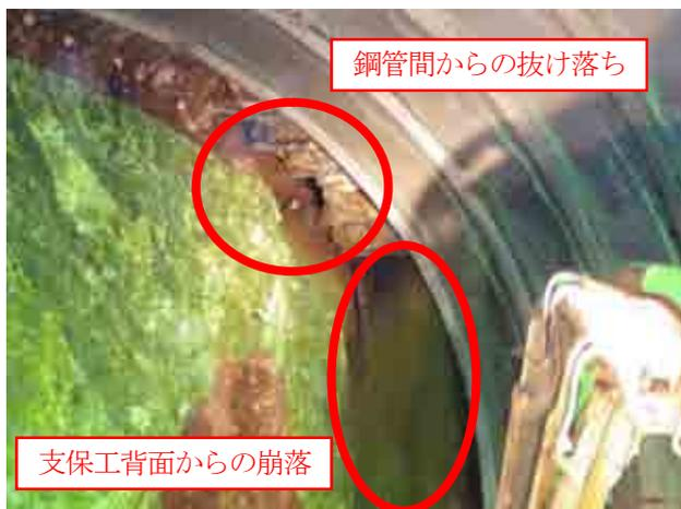
図 - 7 切羽肩付近からの崩落
