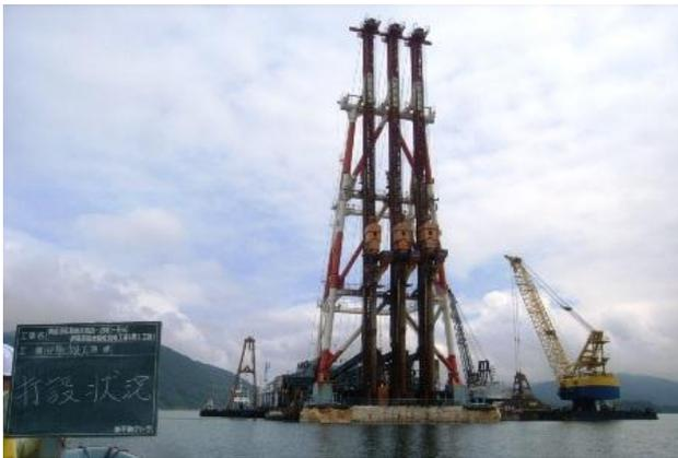
図-6 SCP船による地盤改良状況
