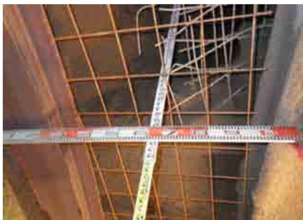
図 - 8 鋼管間からの抜け落ち (約4m)
