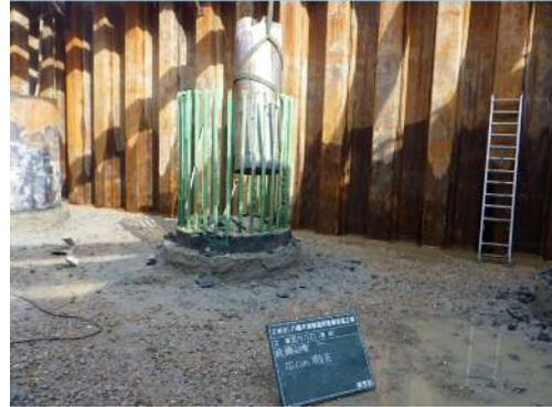
写真-10 キャップ芯吊り上げ状況
