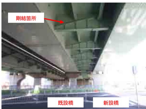
写真 3-1 C ランプ拡幅状況
