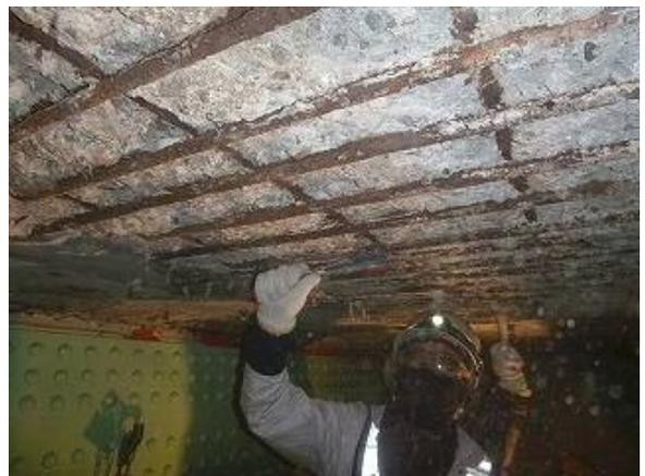
写真 5-6 既設床版鉄筋の発錆状況
