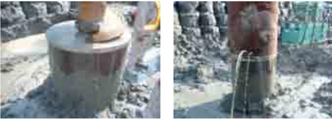
図-10. 被圧地下水溢れ出し状況
