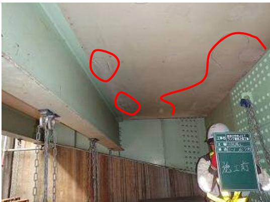
写真 5-2 床版補強異常音範囲 (赤枠内)
