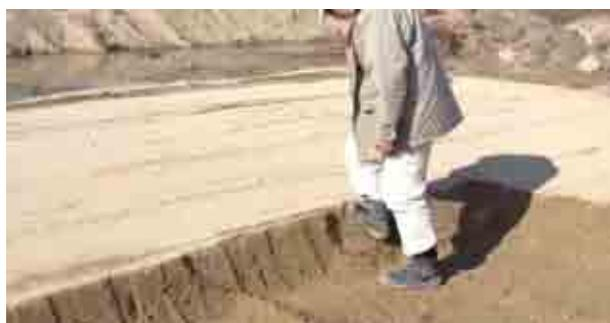
写真-2 転圧後、締まってないため簡単に崩壊した次に試料採取し室内試験を行った。河道掘削した土砂と併せて、隣接して仮置きしている大阪府の建設発生土も採取し、「土の含水比試験」（JIS A 1203）、「土の粒度試験」（JIS A 1204）、「土のコーン指数試験」（JIS A 1228）を実施し、河川土工マニュアル（2009 年 11 月）を基準に築堤材料としての適否を考察した。
