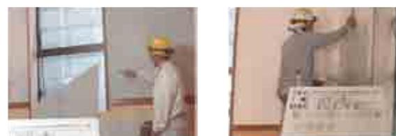
漆喰施工状況（下地調整、材料練り混ぜ、仕上げ）
