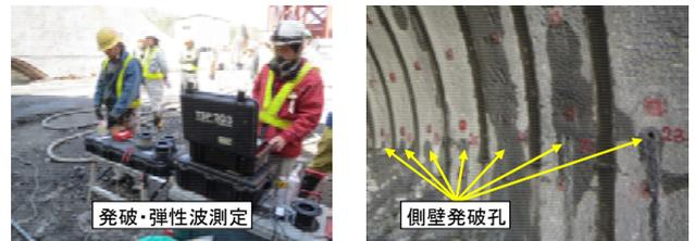
写真-1 TSP切羽前方探査実施状況
