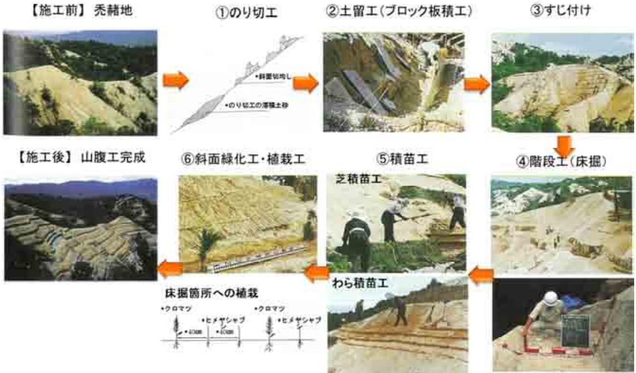
図9 山腹工施工(例)の流れ
