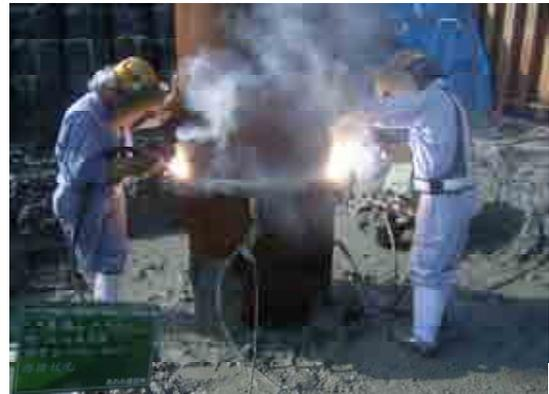
図-17. 継ぎ杭溶接作業状況
