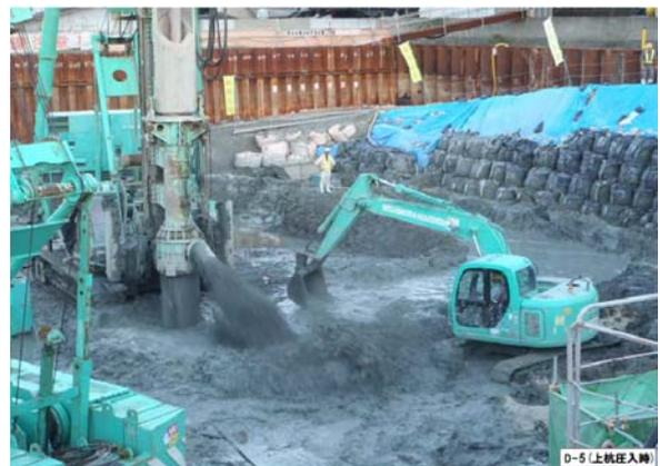
図-9. 泥水の拡散状況
