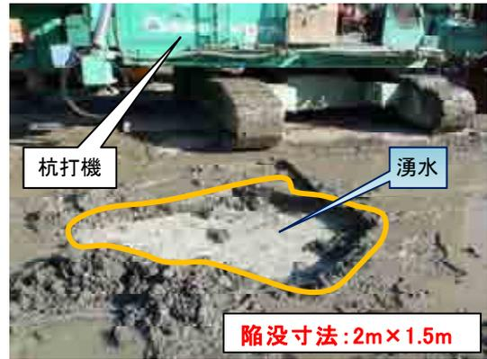
図-11. 施工基盤陥没状況
