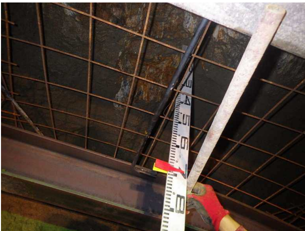
図-5 天端鋼管下部からの剥落 (t=700mm)
