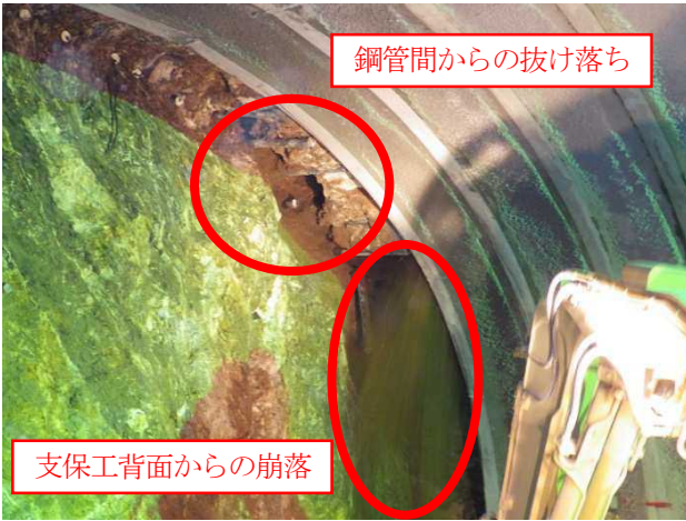
図 - 7 切羽肩付近からの崩落
