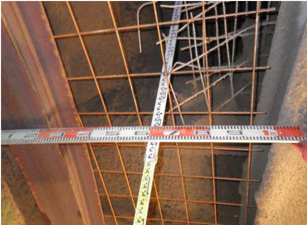
図 - 8 鋼管間からの抜け落ち (約4m)
