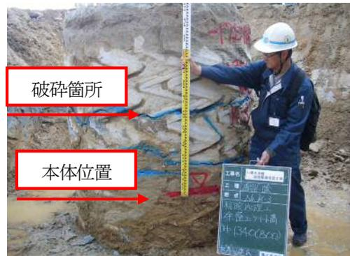
写真-6 破碎完了
