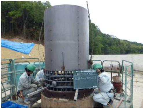
写真-8 杭キャップ設置状況
