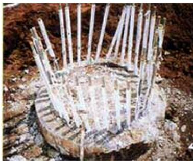
写真-4 人力はつりにより曲がった鉄筋の例
