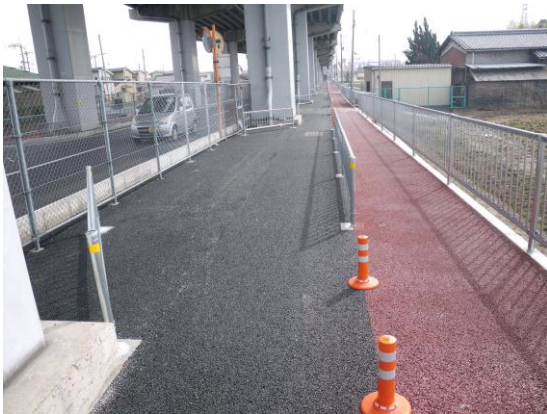
写真-4 整備後の状況
