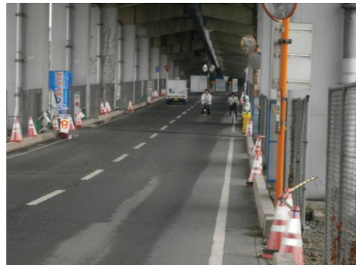
写真-2 整備前の状況
