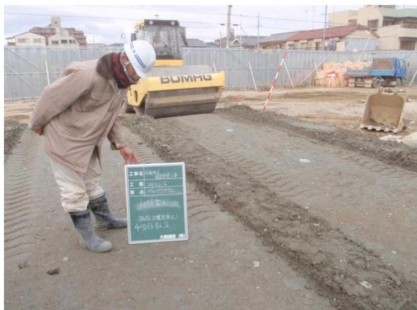
写真-6 二種混合した盛土材の試験転圧状況
