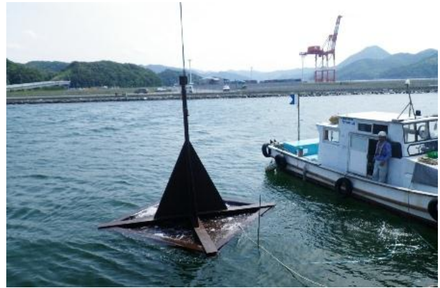
図-8 沈下板設置状況
