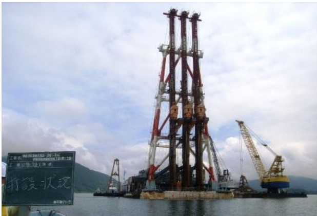
図-6 SCP船による地盤改良状況
