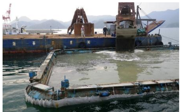
図-5 敷砂投入状況
