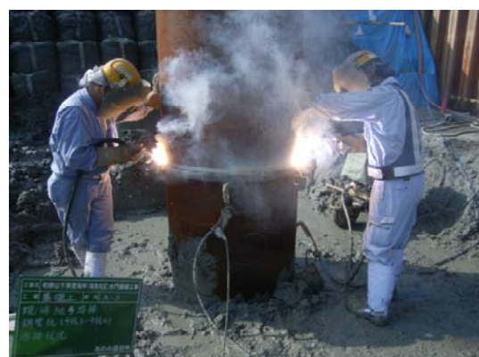
図-17. 継ぎ杭溶接作業状況
