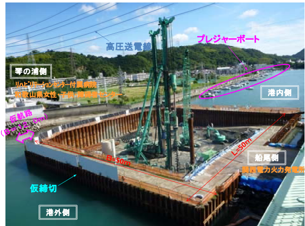
図-6. 施工位置状況写真
