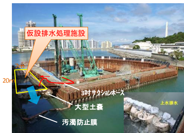
図-15. 仮設排水施設設置状況
