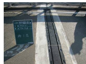
伸縮装置復旧
