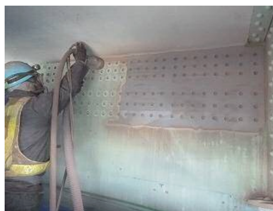
写真 4-1 バキュームブラスト施工状況
