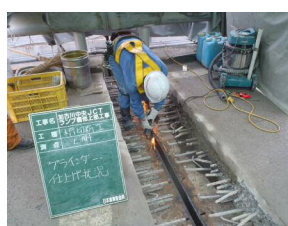
桁切断状況
