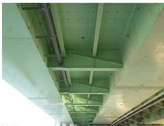
写真 5-5 鋼板接着工
