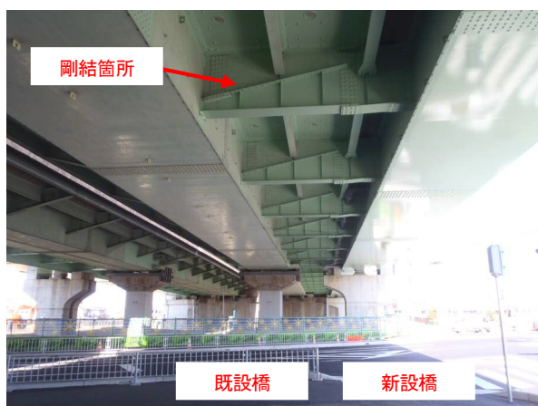
写真 3-1 C ランプ拡幅状況
