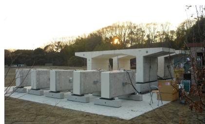
写真－1 供試体設置状況
