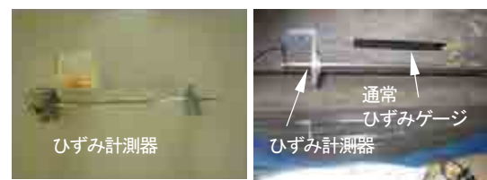
写真-3 計測器の設置状況
