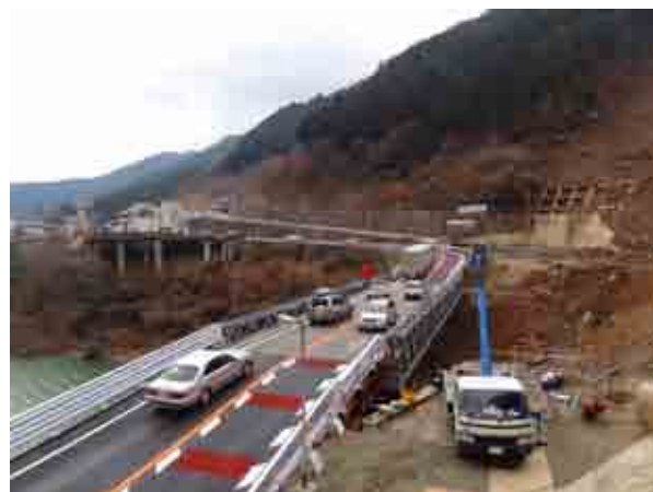
図-3 応急組立橋による国道 169 号の応急復旧
