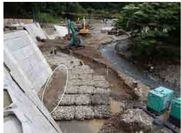
写真-7 根固工施工時の状況
