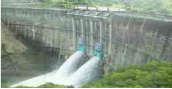
写真-2 コンジットゲートより放流中の真名川ダム
