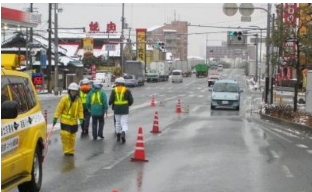
写真-3 清滝峠における交通規制の状況
