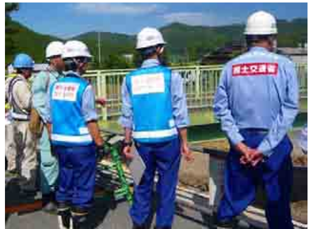
図-6 応急組立橋の出動に向けた国道162号の現地調査
