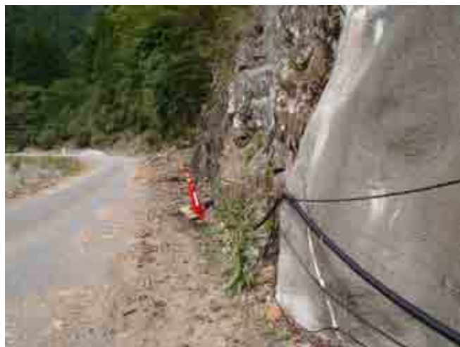
図-3 NTTケーブル敷設状況
