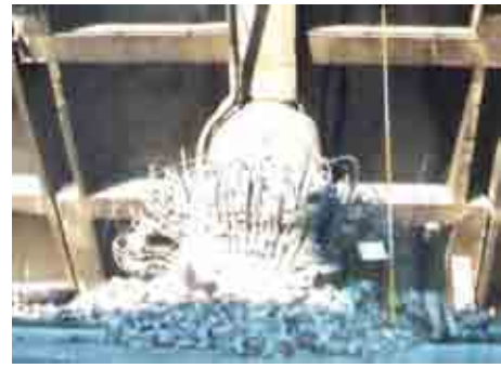
鉄筋が全周の外側に座屈 図-9 ビルツ橋脚の特殊破壊・神 P133 7,20)
