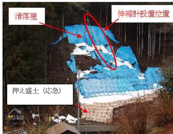
写真3.5 伸縮計の設置位置、滑落崖、押え盛土
