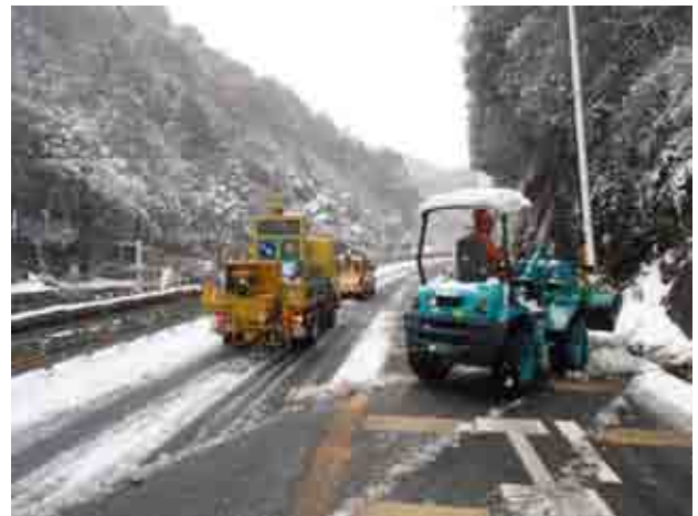
写真-2 除雪機械の稼働状況 (2014年2月14日 孝子峠にて)
