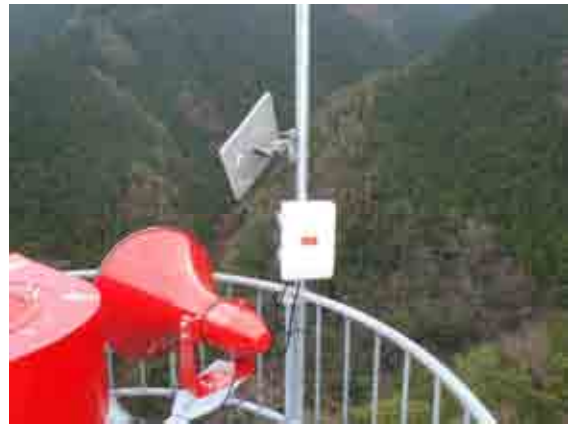
図-9 猿谷ダム管理支所設置状況
