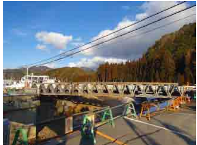
図-9 応急組立橋による国道 162 号の応急復旧
