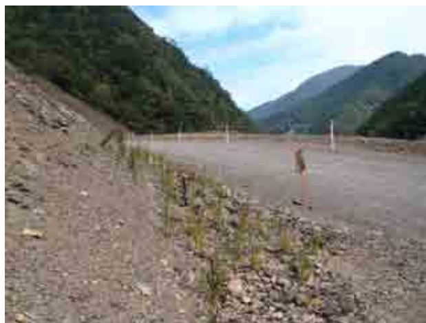
図-4 県道 仮復旧状況
