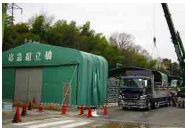
図-1 応急組立橋の保管（派遣時に撮影）のテント倉庫で保管している。保管の様子を図-1に示す。各部材ごとに整理し、緊急時に速やかに派遣できる状態で保管している。また、応急組立橋の部材だけでなく、高力ボルトなどの消耗品も常に備蓄して、派遣に備えている。
