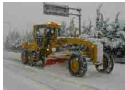
写真3-3 除雪状況(除雪グレーダ)
