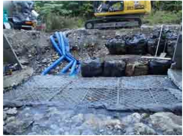
写真-8 基礎鋼製枠施工時の状況
