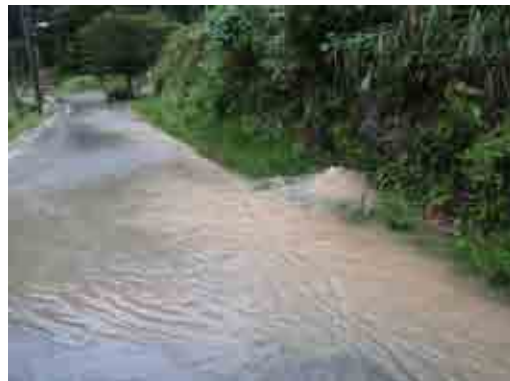
写真-3 路側からの湧水 (9/16 9:30頃)
