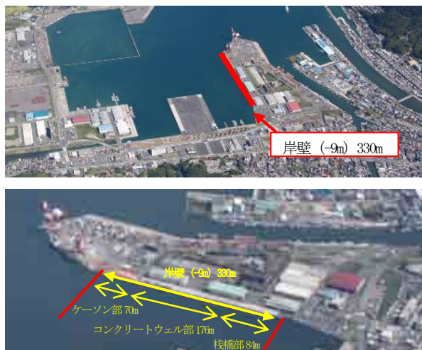
図-2 舞鶴港第2ふ頭地区全景
