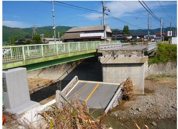
図-5 平成25年台風18号による国道162号の被災
