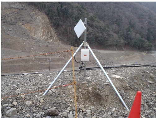
図-7 赤谷河道閉塞箇所設置状況
