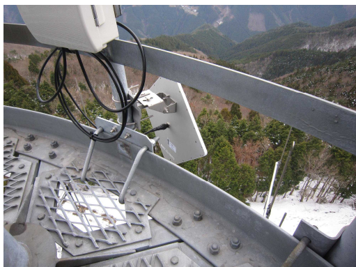
図-8 白六山無線中継所設置状況
