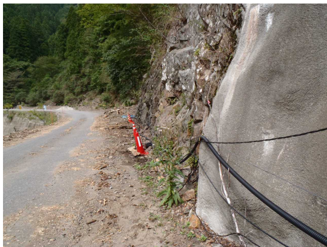
図－3 NTTケーブル敷設状況
