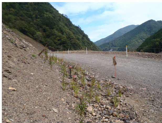
図－4 県道 仮復旧状況
