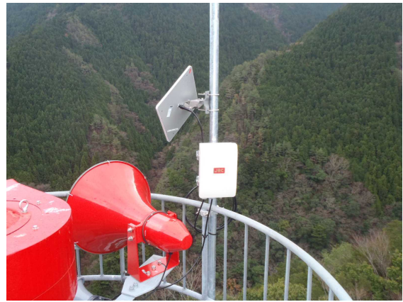
図-9 猿谷ダム管理支所設置状況
