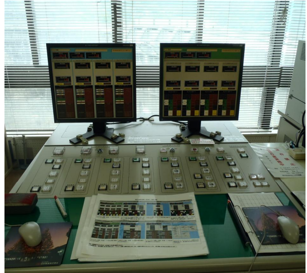
写真8 遠方手動操作装置 操作卓
