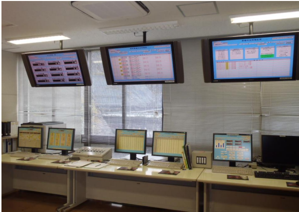
写真3 放流操作設備
