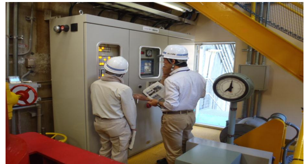
写真6 ゲート機側操作盤での操作訓練
