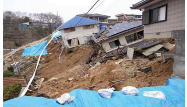
写真-1 あさひ台団地(Case_1)の被災状況(2011年5月5日撮影)
