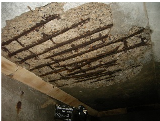
栈橋下面部の鉄筋露出状況
