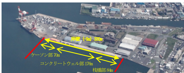
図-2 舞鶴港第2ふ頭地区全景
