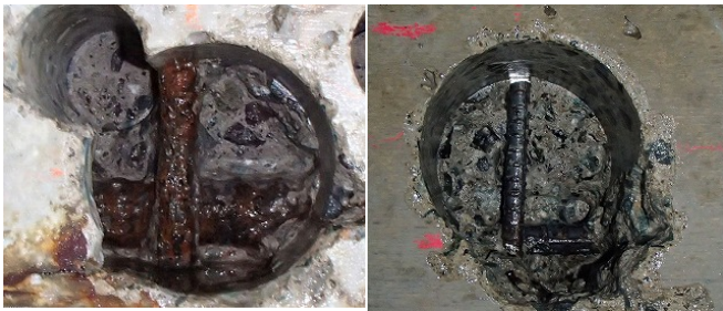
【コンクリートウェル部】
