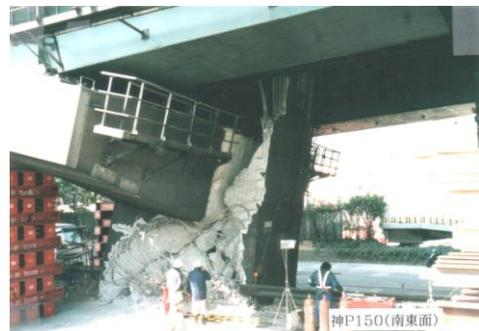
図-11 神P150, 圧縮破壊だが裸鉄筋直立<sup>20)</sup>
