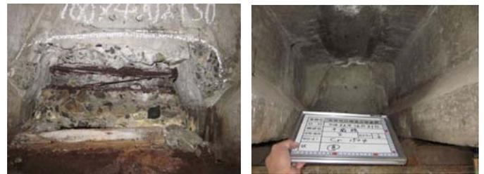
写真-1 横桁及びPCケーブルの破断状況
